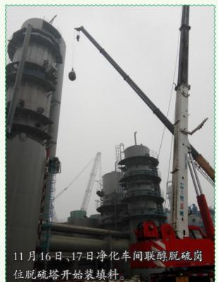
11月16日、17日净化车间联醇脱硫岗位脱硫塔开始装填料。
