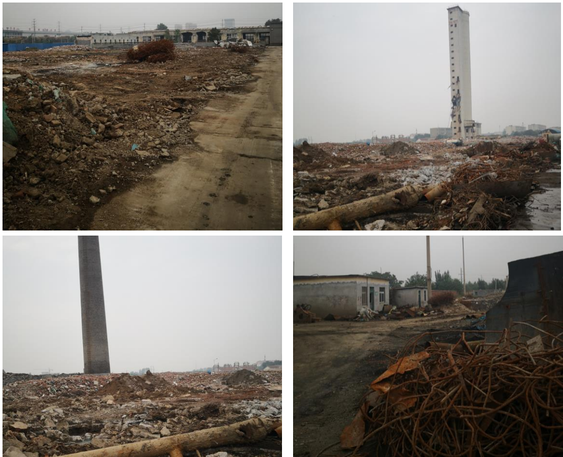
图 2.1-3 基本拆除后现场情况
