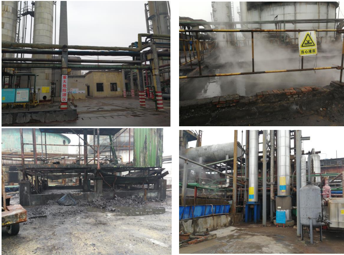
图 2.1-2 未拆除前现场情况
