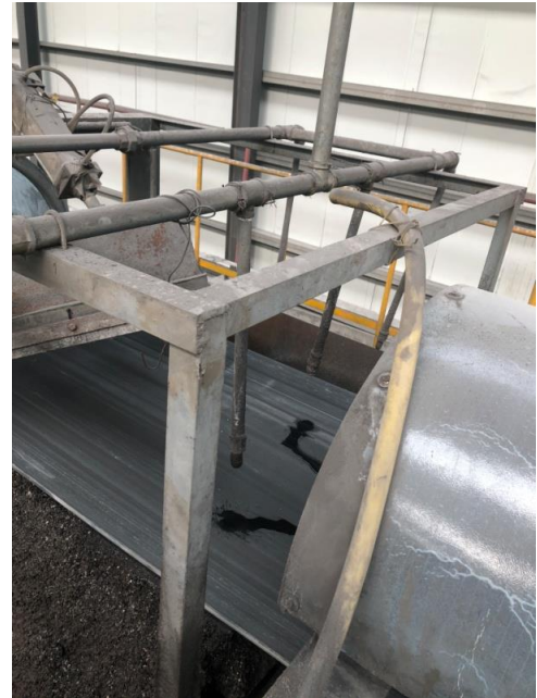
输送皮带喷淋系统
