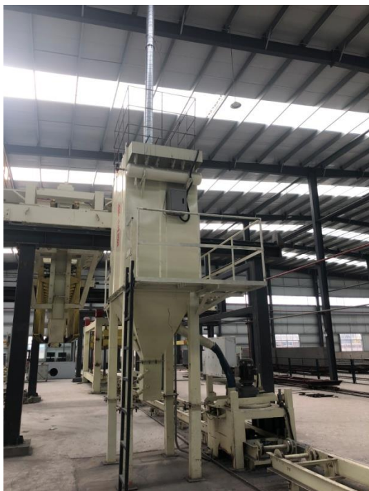
侧板清理废气处理设施
